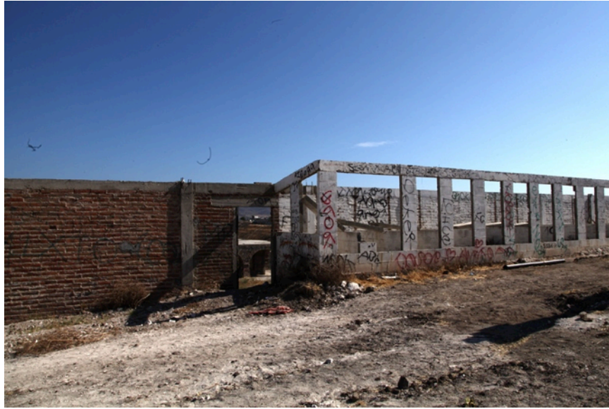
Figura 1. “Predio la gallera”, de Colectivo RECO
